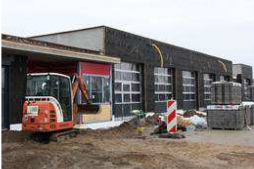
Neubau der Rettungswache Angermünde
